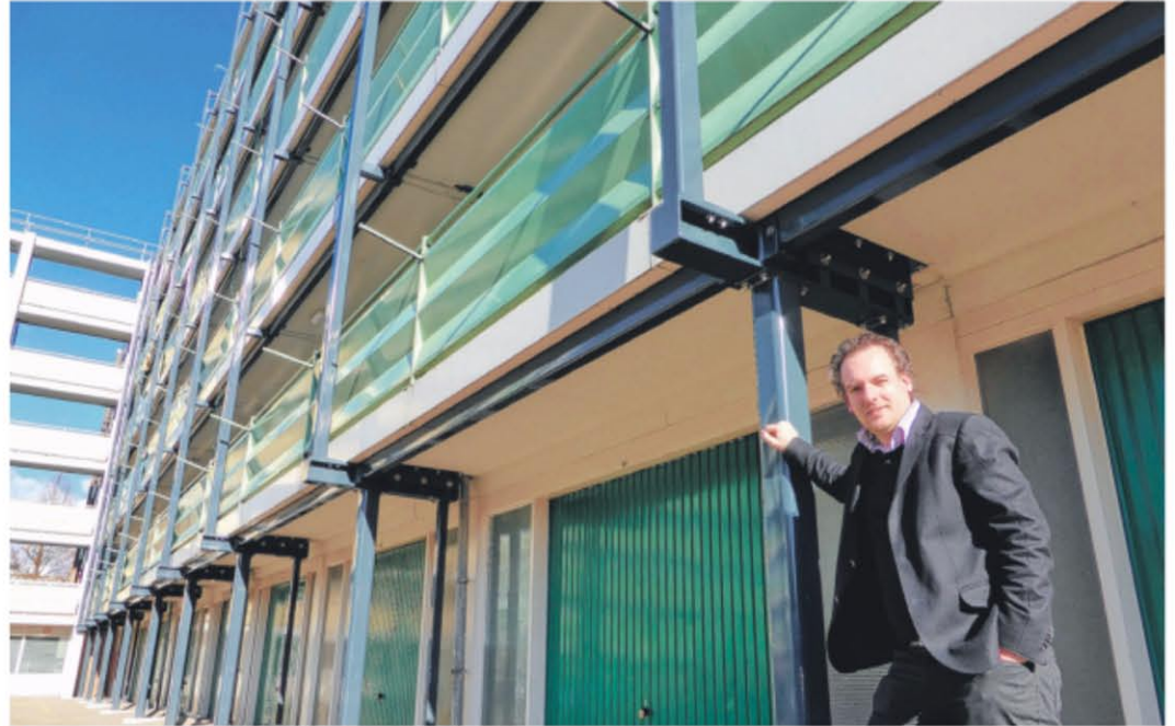
■ Dirkjan van Es bij de Nachtegaal, een van de flats met de nieuwe staalconstructie, ontworpen door het Sliedrechtse architectenbureau.
