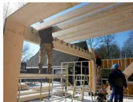
Opbouw van het houten skelet
